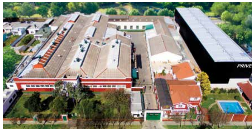
Vista aérea de la planta industrial de Prive Cerraduras y Laminación S.A.I.C.
